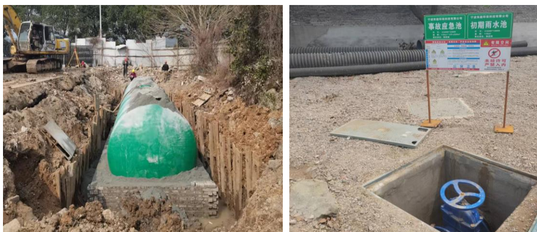
图 4.1-3 初期雨水池、切换阀
