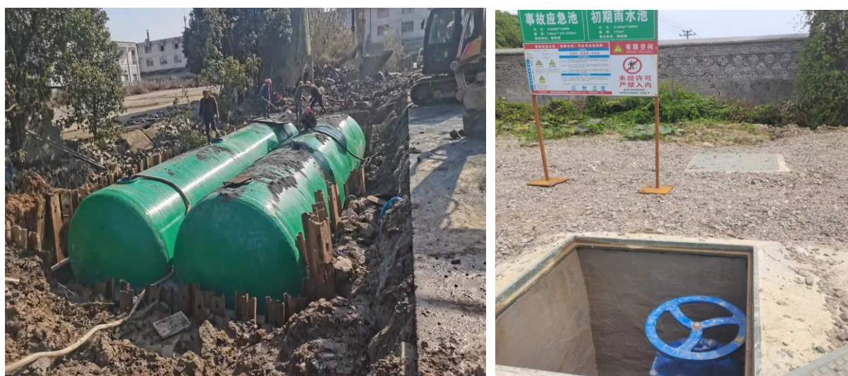
图 4.2-1 事故应急水池及切换阀
