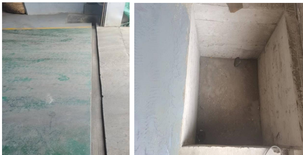
图 4.1-2 仓库各车间设置的导流沟、收集池
