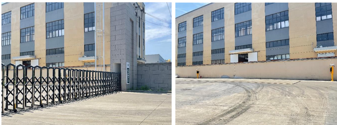
图 3.5-1 固体废物出入口及地磅
