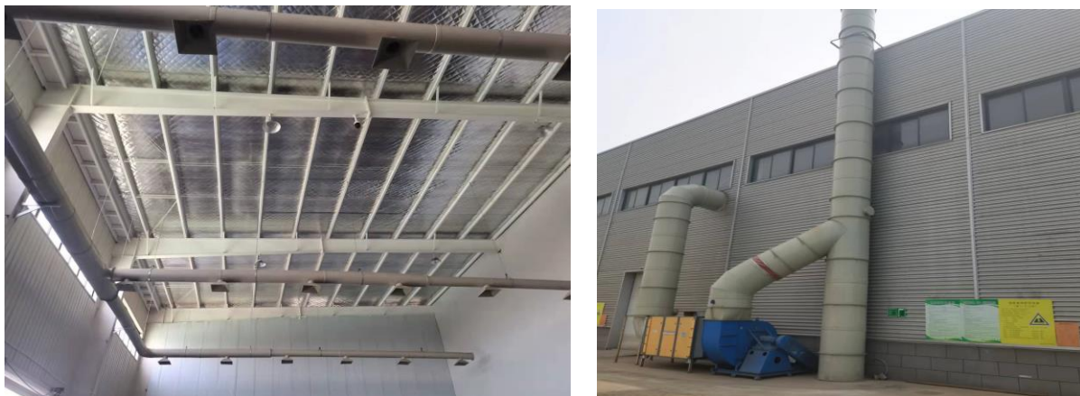
图 4.1-1 贮存车间负压引风系统、活性炭吸附装置
